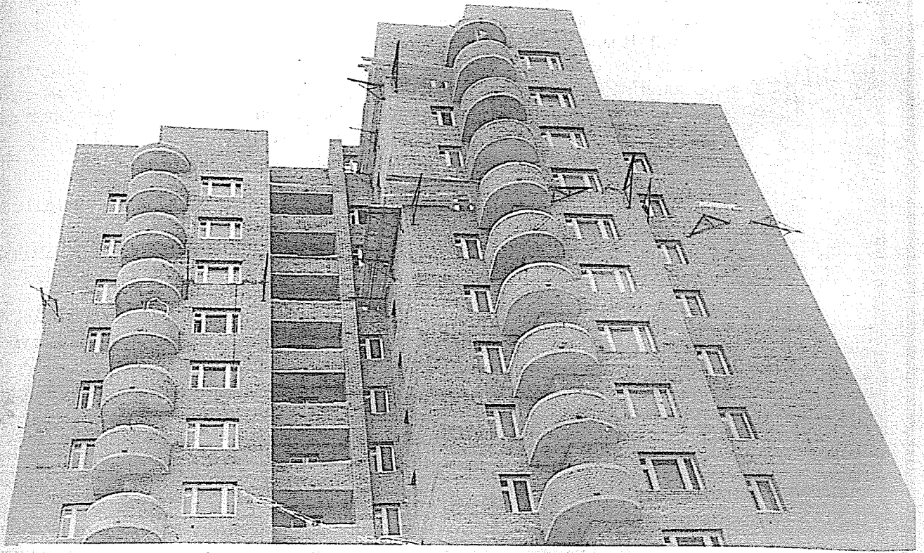
Жилой дом (г. Глазов): Архитектор Ю. Эпельбаум; инженеры: Л. Песегова, Е. Цукерман
