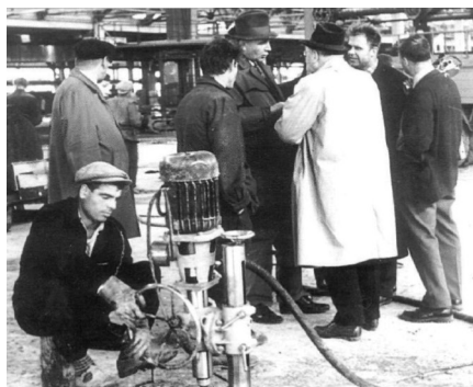
Испытания станка для алмазного сверления бетона и железобетона (конструкция ТПИ) на строительстве ВАЗа.
